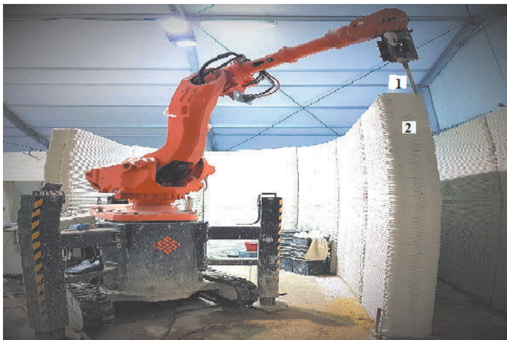
1 — сопло экструдера; 2 — конструкция сооружения
