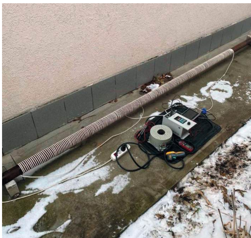
Рисунок 4. Экспериментальная установка для нагрева участка трубопровода
