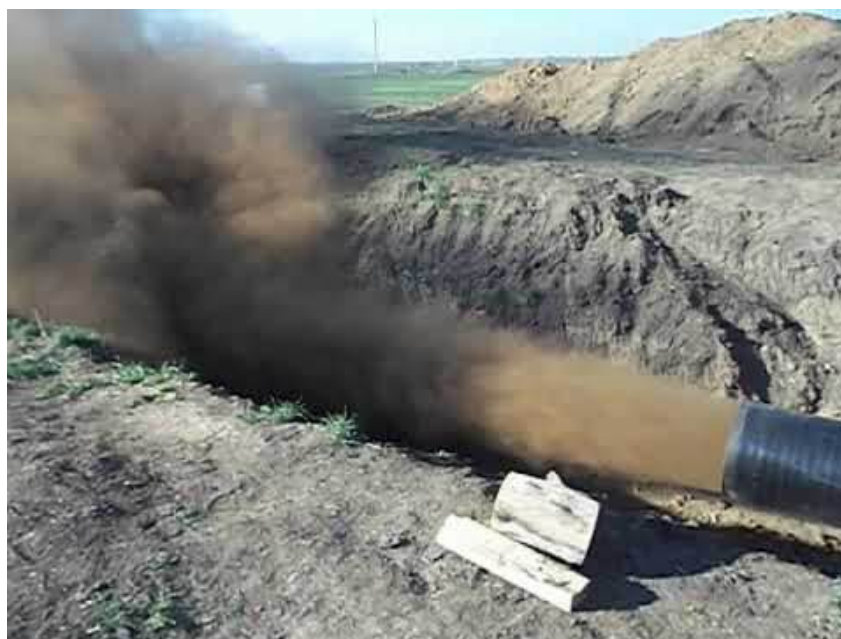
Рисунок 5. Очистка трубопровода методом продувки
