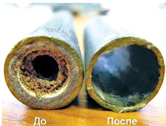
Рис. 2. Трубопровод до и после промывки
