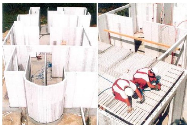
Рис. 4. Возведение дома из пористого бетона
